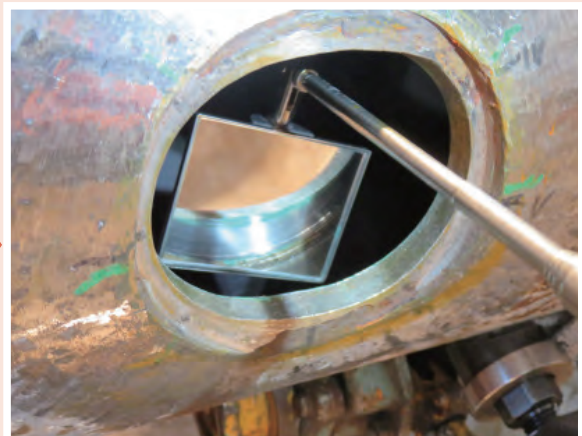
ハンドホール面圧座 加工後
