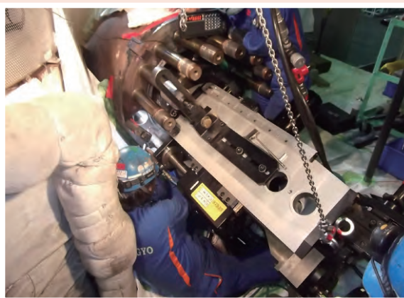
主蒸気弁 MSV 本体植込みボルト採取り・サイズ UP
