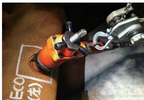
検査孔蓋（ガット）取り外し加工
